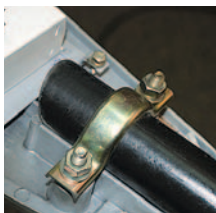
Узел крепления к кронштейну
